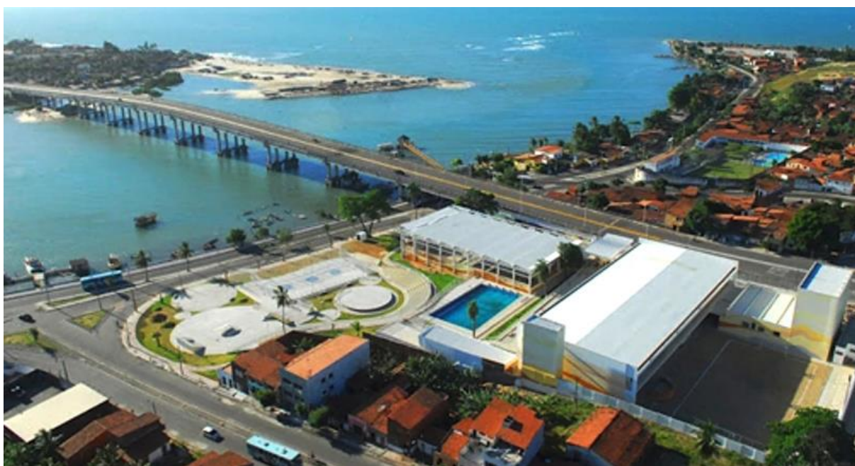
Figura 53 - Vista aérea do CUCA da Barra junto ao Rio Ceará.
