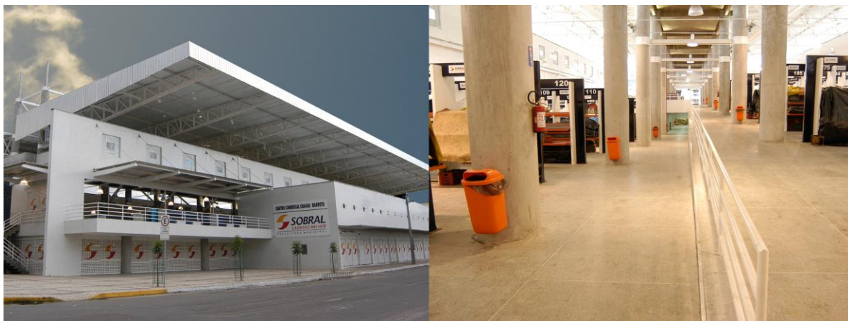
Figura 52 - Mercado de Sobral: fachada principal e pátio rampado central Fonte: Acervo profissional do Arquiteto Ricardo Muratori.
