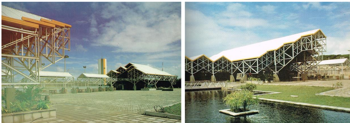
Figura 31 - Clube dos Funcionários da Petrobrás. Fonte: Acervo do arquiteto Ricardo Paiva.
